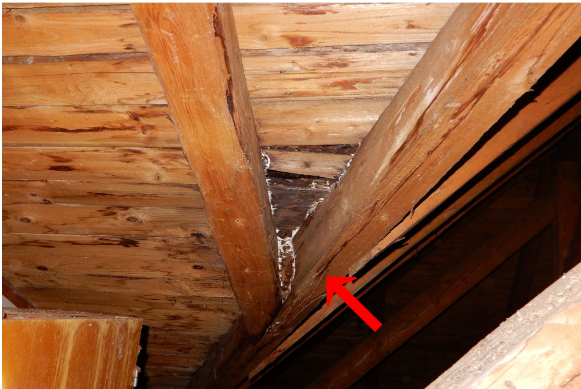
Ohnisko č. 1 – Hnilobou poškozená úžlabní krokev a prkenné bednění s bělavým povlakem dřevokazné houby Trechispora stevensonii
