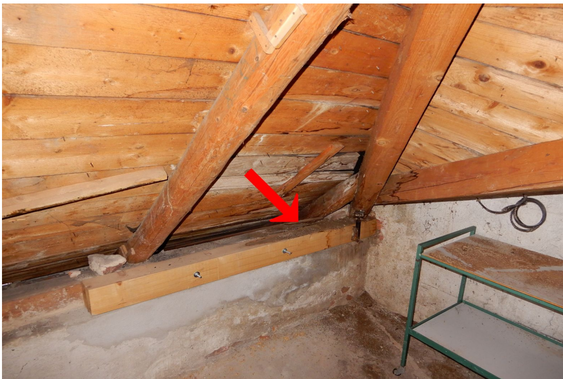
Ohnisko č. 2 – Hnilobou celulozovorního basidiomycetu řádu Aphylllophorales silně poškozený konec pozednice
